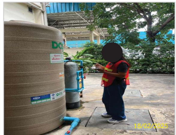
ข) เจ้าหน้าที่คอยตรวจสอบระบบบำบัดน้ำเสียสำเร็จรูป
